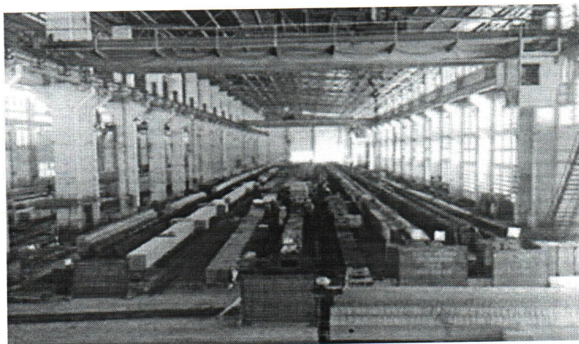
Dây chuyền sản xuất bê tông dự ứng lực
